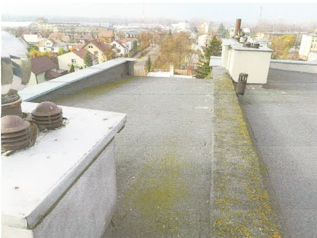
Fot. 7 Widok dachu.
