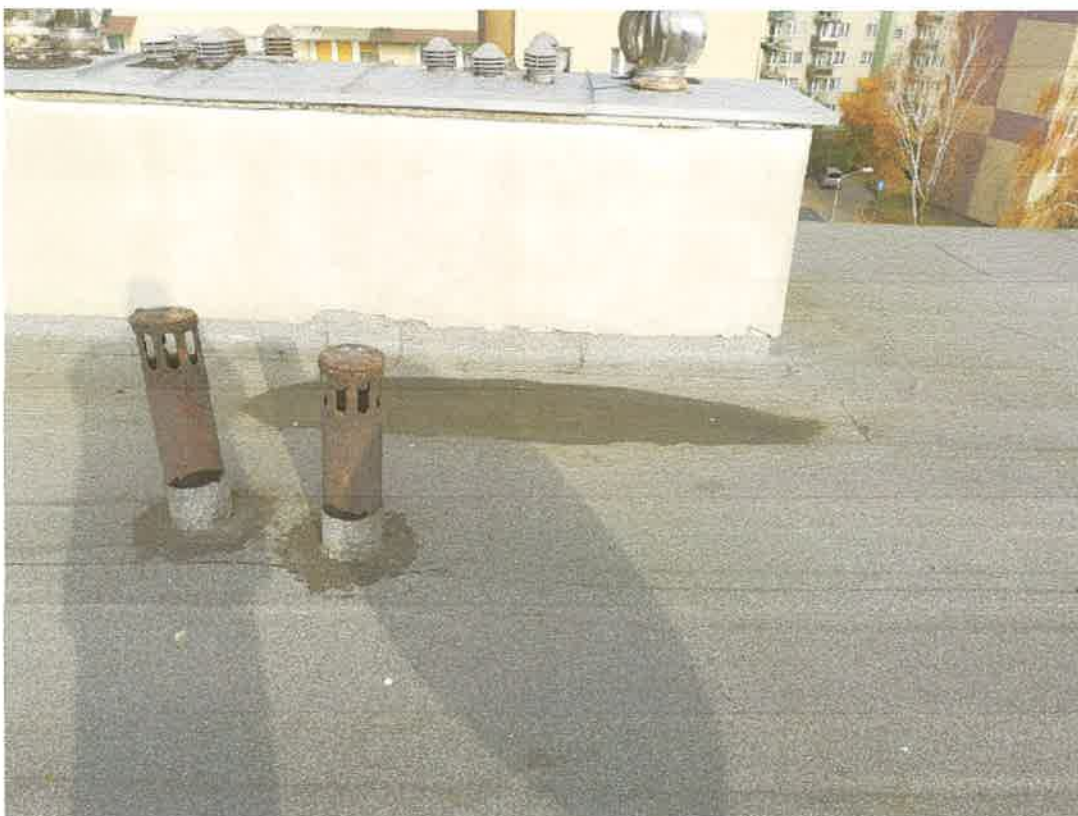
Fot. 8 Widok kominów.
