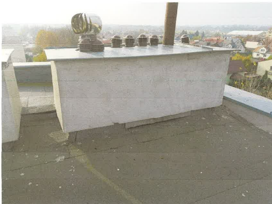
Fot. 5 Widok kominów.
