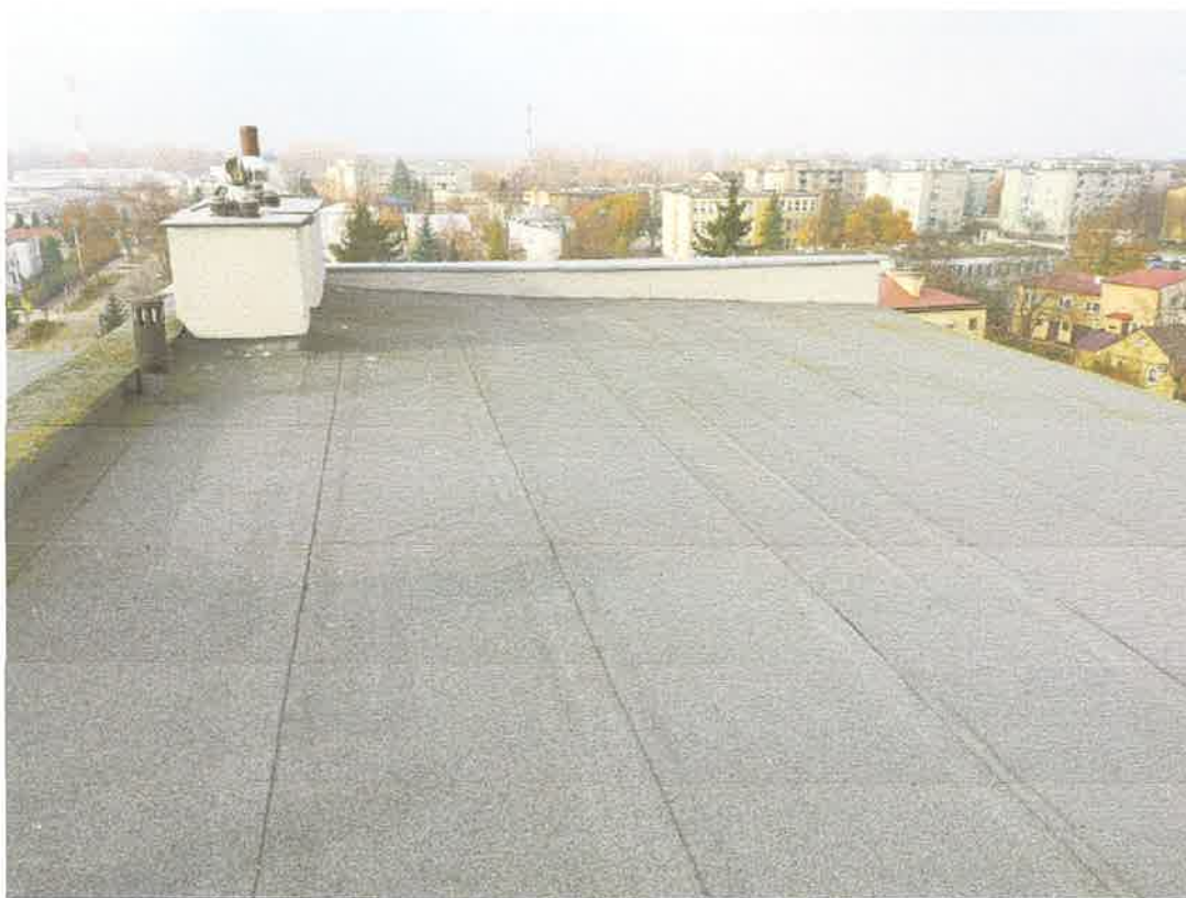
Fot. 4 Widok dachu.
