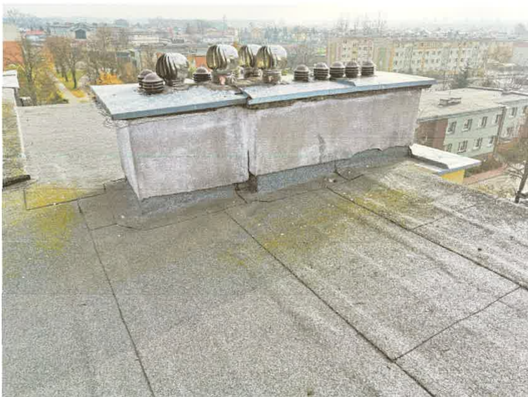
Fot. 9 Widok kominów.
