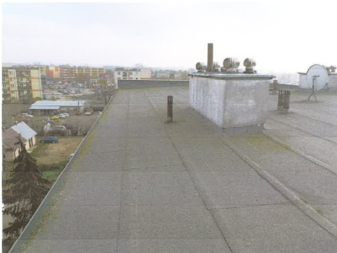
Fot. 2 Widok dachu.
