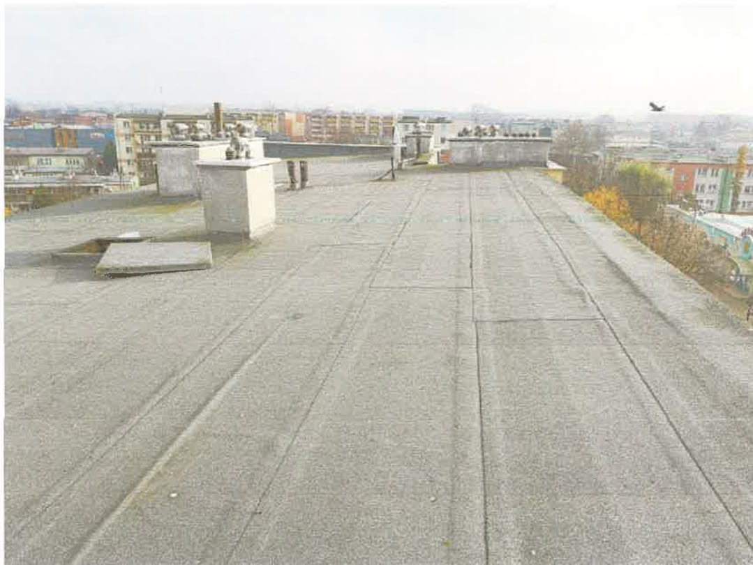
Fot. 3 Widok dachu.
