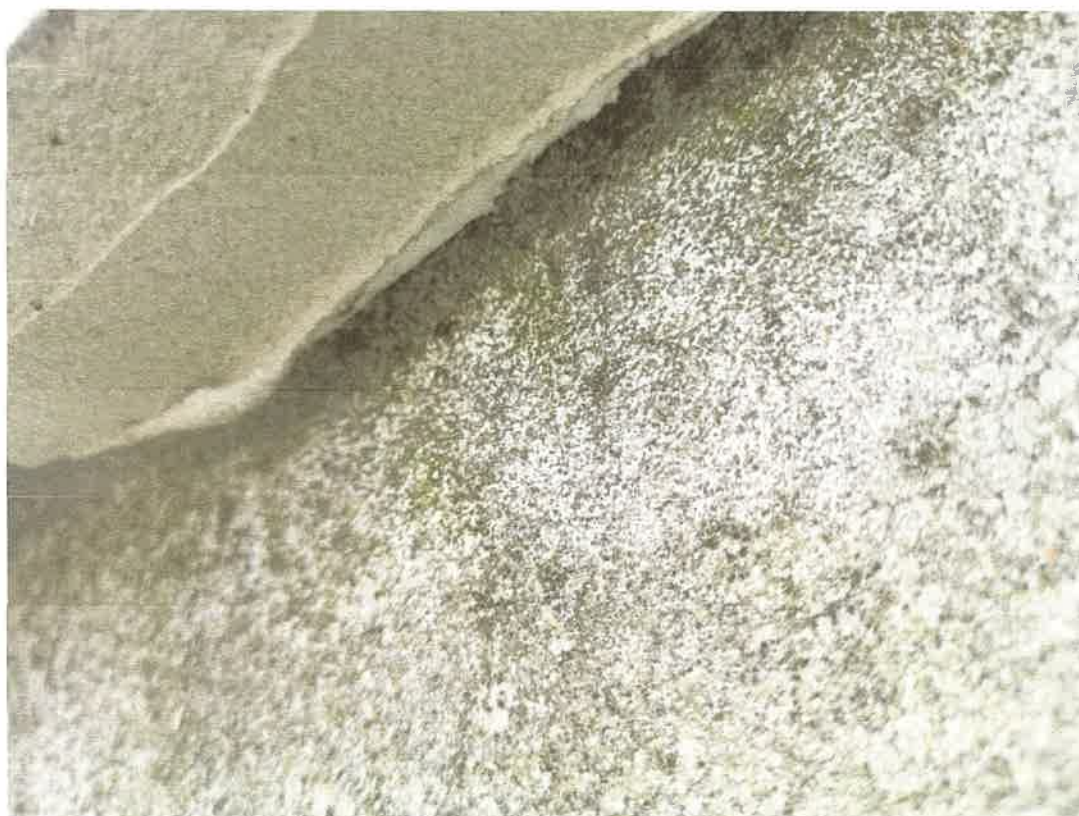
Fot. 6 Połączenie komina z połącią dachową.
