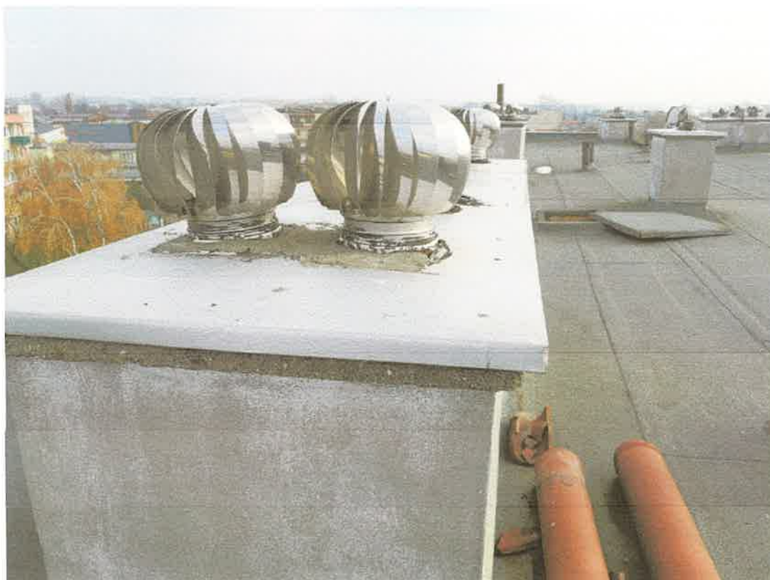
Fot. 12 Obróbka nasad kominowych.
