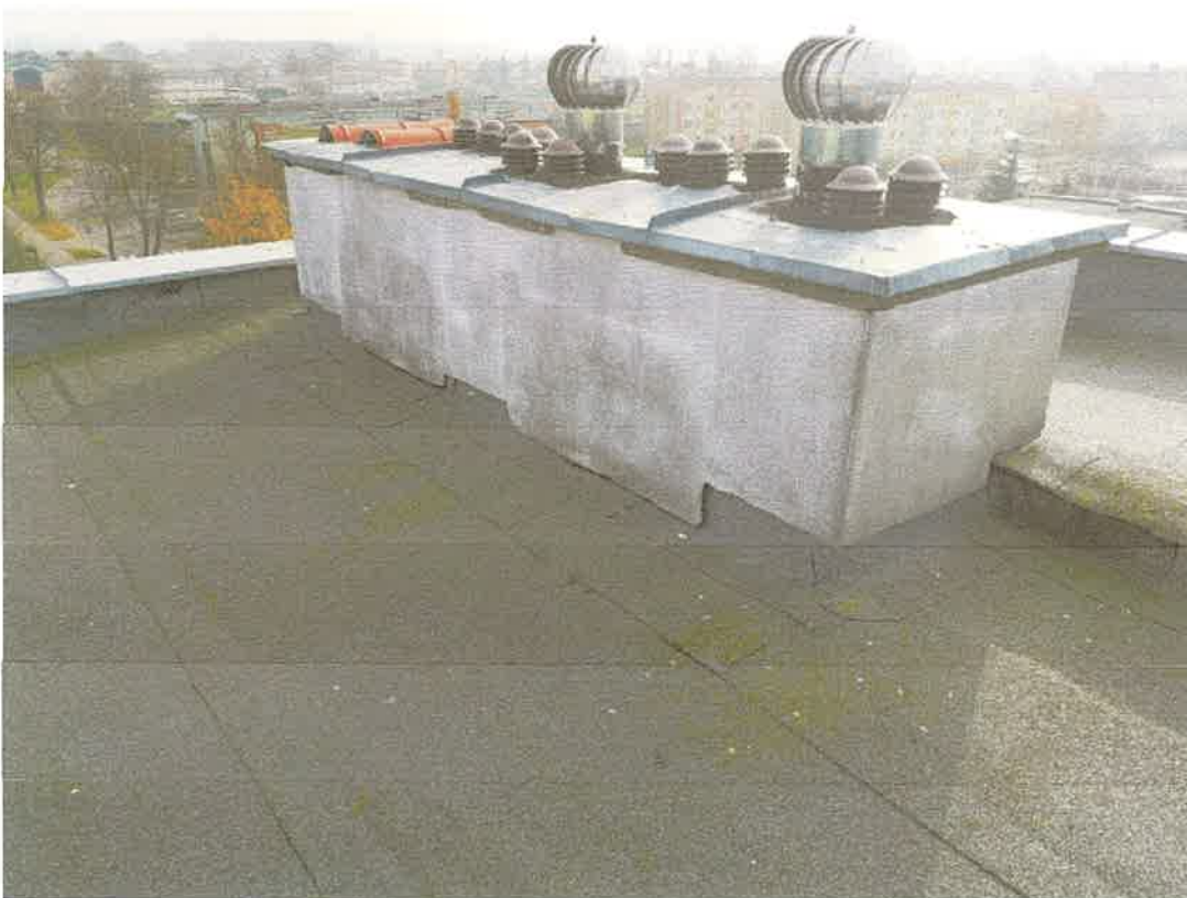
Fot. 10 Widok kominów
