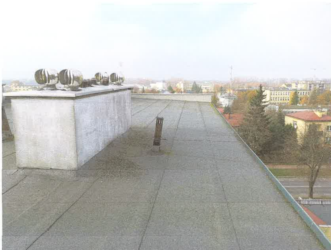
Fot. 1 Widok dachu.
