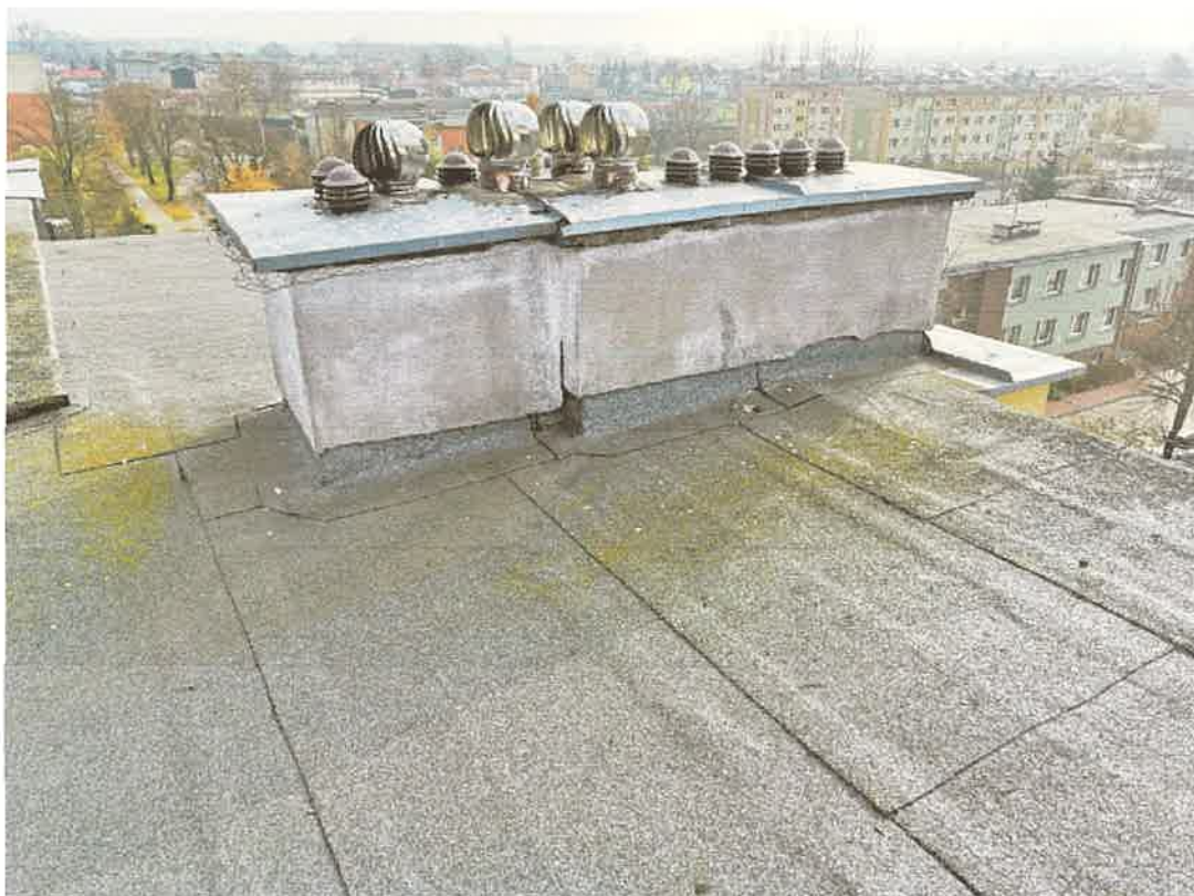
Fot. 9 Widok kominów.
