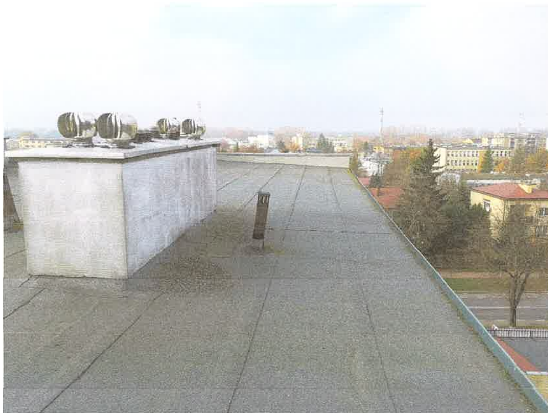
Fot. 1 Widok dachu.
