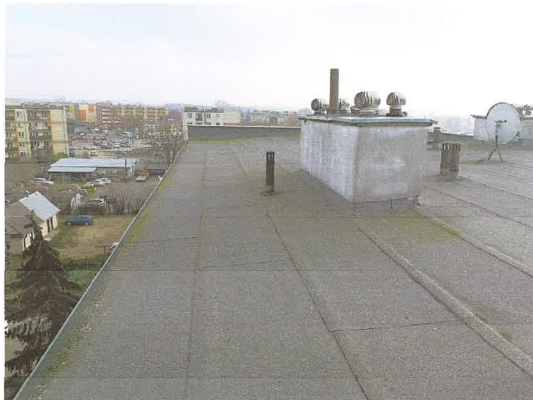
Fot. 2 Widok dachu.
