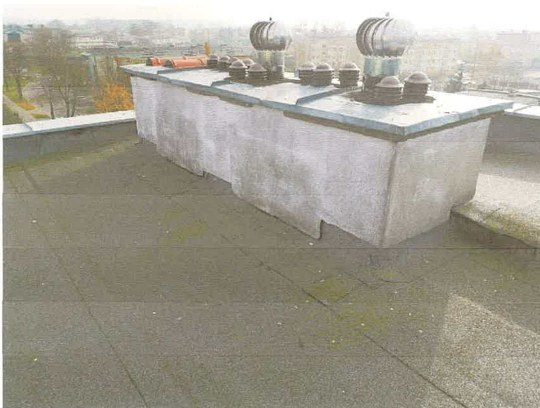
Fot. 10 Widok kominów
