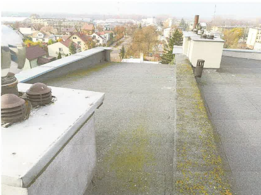
Fot. 7 Widok dachu.
