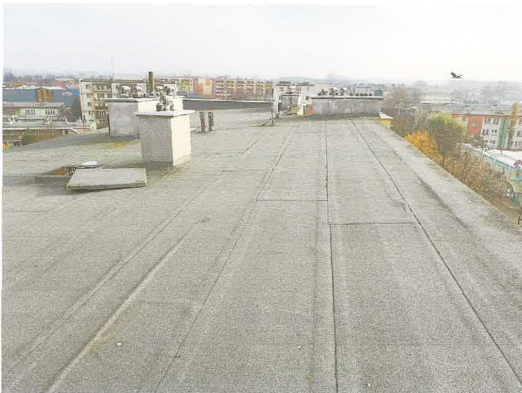
Fot. 3 Widok dachu.
