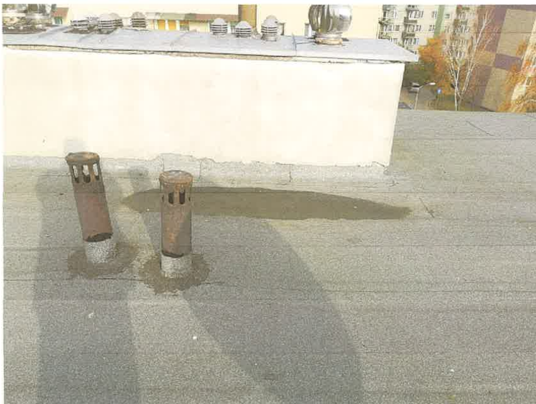
Fot. 8 Widok kominów.
