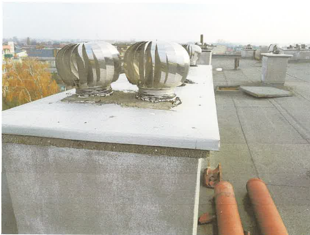
Fot. 12 Obróbka nasad kominowych.
