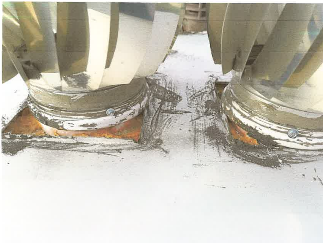
Fot. 11 Obróbka nasad kominowych.
