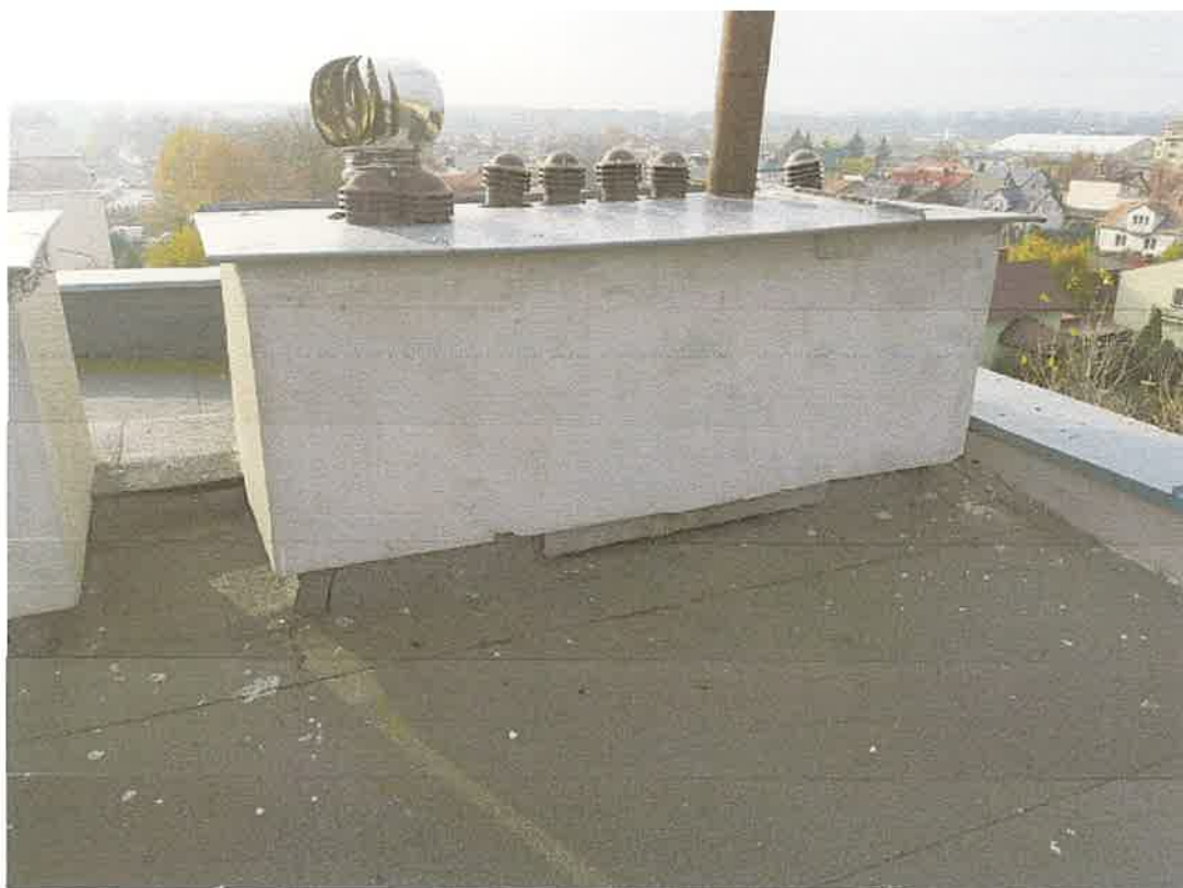
Fot. 5 Widok kominów.
