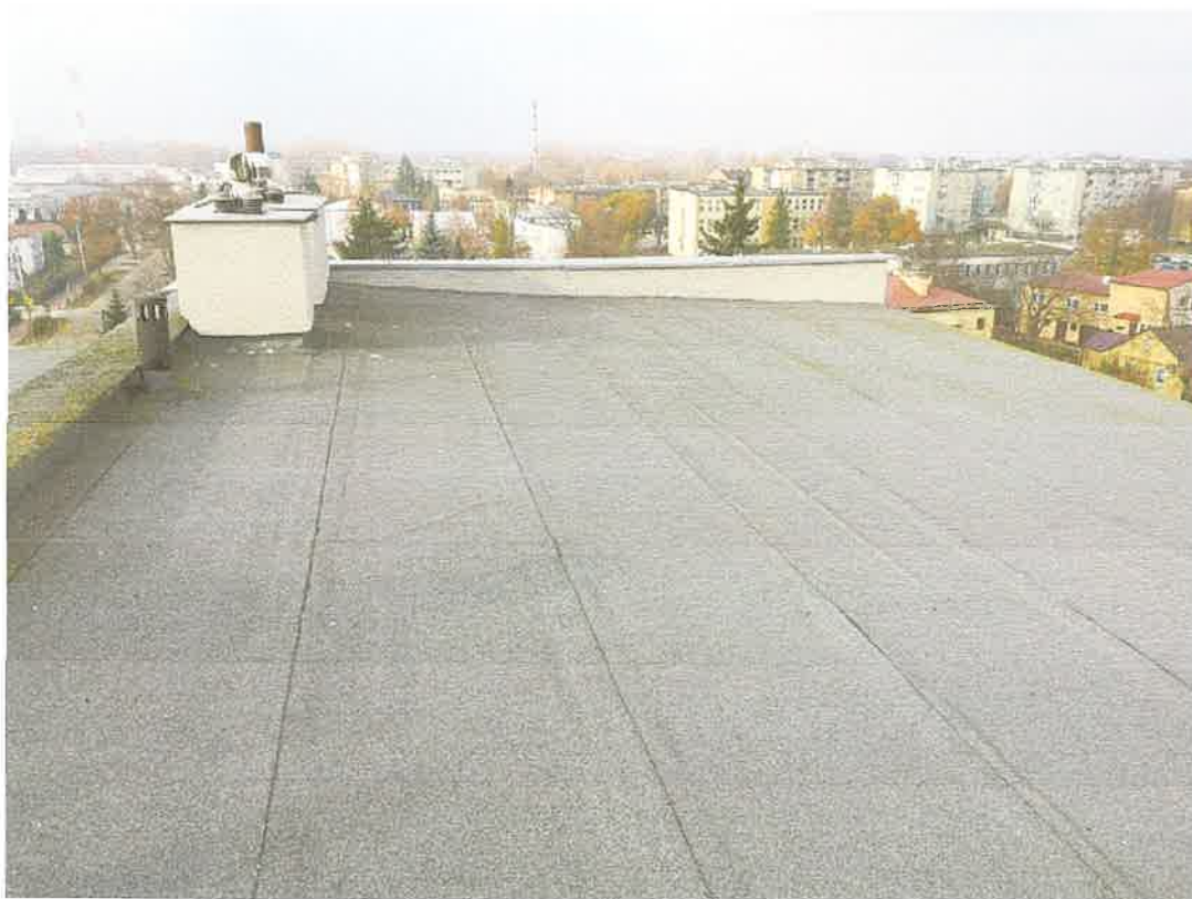
Fot. 4 Widok dachu.
