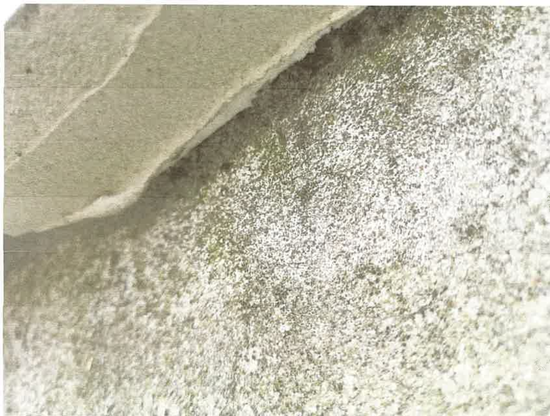
Fot. 6 Połączenie komina z połącją dachową.
